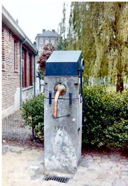
*Cette pompe en pierre de forme quadrangulaire est dotée d'un conduit d'écoulement en cuivre situé en hauteur. L'amortissement en zinc renferme la partie supérieure du mécanisme de pompage.*
